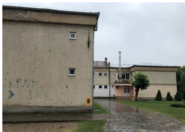
Fig.3a Vedere dinspre Nord
